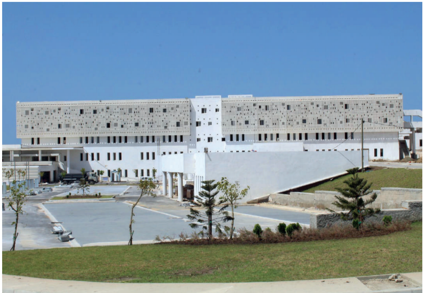
Le CHU de Tanger fait partie des nouveaux établissements que le Plan Santé 2025 se propose de bâtir. Aujourd'hui, le Maroc compte six centres hospitaliers universitaires opérationnels à Casablanca, Rabat, Fès, Marrakech, Tanger et Oujda, deux en cours de construction à Agadir et Laâyoune et trois en cours d'études à Errachidia, Béni Mellal et Guelmim (Ph. L'Economiste)
