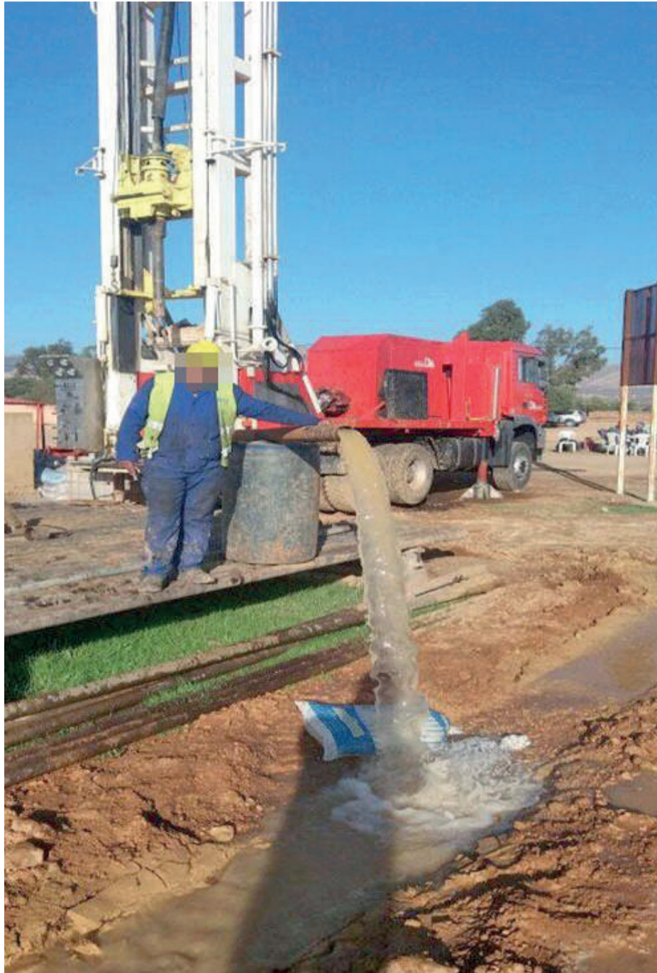
Par méconnaissance de la loi ou par défiance, de nombreux propriétaires procèdent au creusement de puits sans en demander l'autorisation auprès des instances concernées
