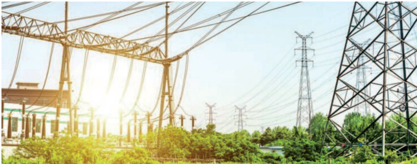
La capacité d'accueil est la quantité maximale en puissance installée à partir de sources d'énergies renouvelables, tous niveaux de tensions confondus, que le système électrique national peut accueillir sans poser de contraintes de gestion des moyens de production et de fonctionnement du système électrique (Ph. Privée)
