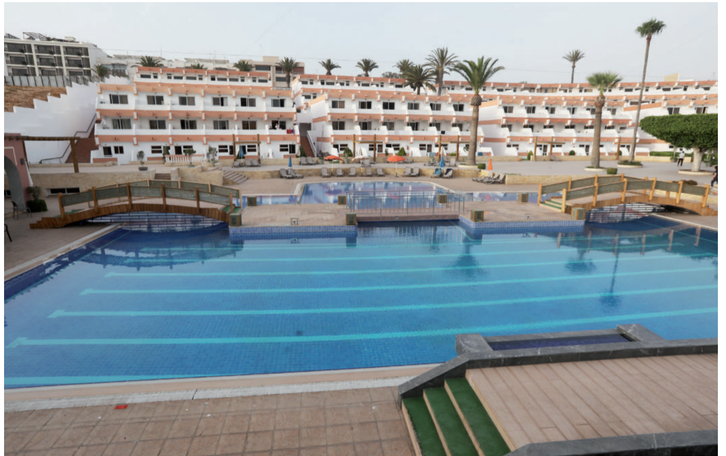
Ce dispositif de relifting des hôtels a pour objectif de mettre à niveau le produit touristique, renforcer l'attractivité de la destination et rehausser les standards et les infrastructures. Le programme devra connaître une extension vers d'autres activités, telles que la restauration, les loisirs... (Ph. Bziouat)
