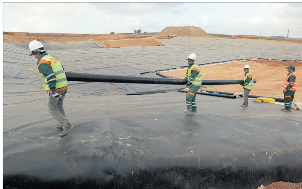
Six décharges contrôlées sont en cours de construction et 23 décharges sauvages ont été réhabilitées alors que 13 sont en cours de réalisation (Ph. Bziouat)
