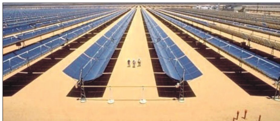
La dernière tranche du complexe de Ouarzazate, Noor IV, sera développée en utilisant la technologie photovoltaïque, avec une puissance minimale de 50 MW (Ph. Modélisation Noor I Masen)
