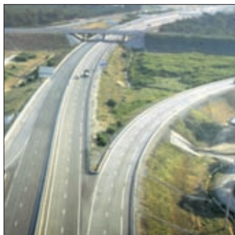
Dès 2015, le réseau autoroutier national devrait atteindre un linéaire de près de 1.800 km reliant l'ensemble des villes du Royaume (Ph. Autoroutes du Maroc)
